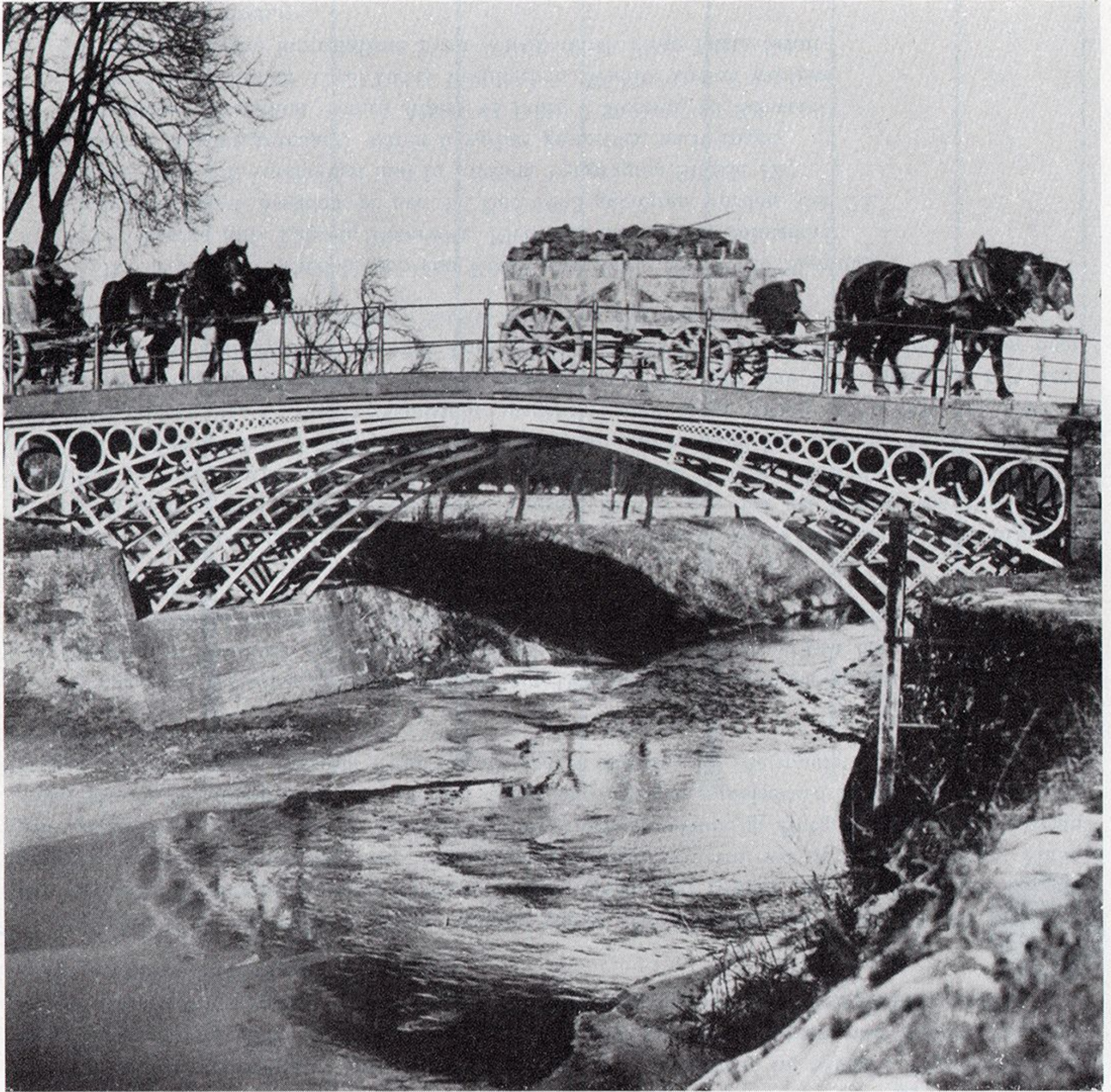
Laasan Kr. Schweidnitz, die gußeiserne Brücke aus dem Jahre 1796 über das Striegauer Wasser. Sie ist die älteste des europäischen Kontinents und mit ihrem Gegenstück, der im Jahrgang 1962 auf Wochenblatt 51 gezeigten und ebenfalls vom Hüttenamt Malapane gegossenen ältesten gußeisernen Hängebrücke, als Ausdruck fortschrittlichen Unternehmergeistes aus der Wende des 18. zum 19. Jahrhundert zu werten
