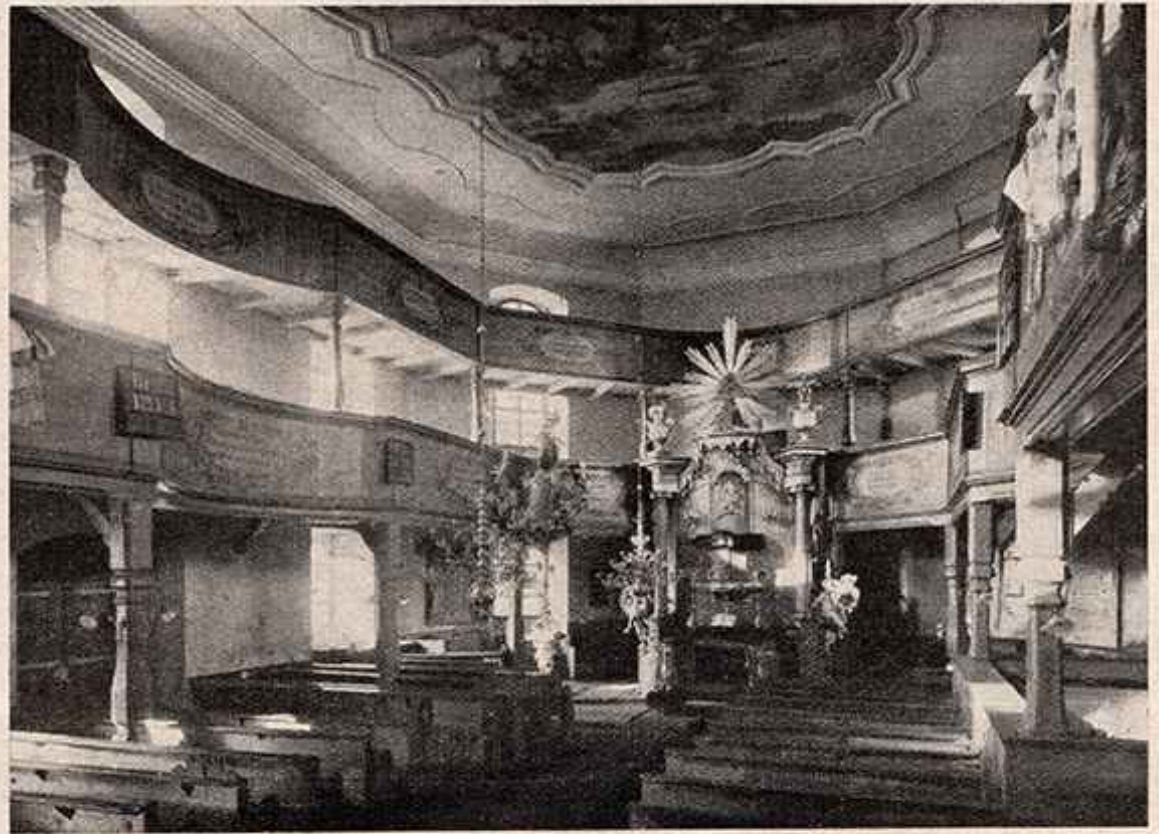
Kirche in Conradswaldau Kr. Schweidnitz, Innenansicht Architekt B. D. A. Herbert Eras
