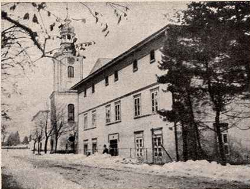
Pfarrhaus Conradswaldau Kr. Schweidnitz, vor dem Umbau Architekt B. D. A. Herbert Eras
